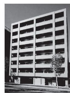
札幌市中央区サザンクロス313(設計・監理)
